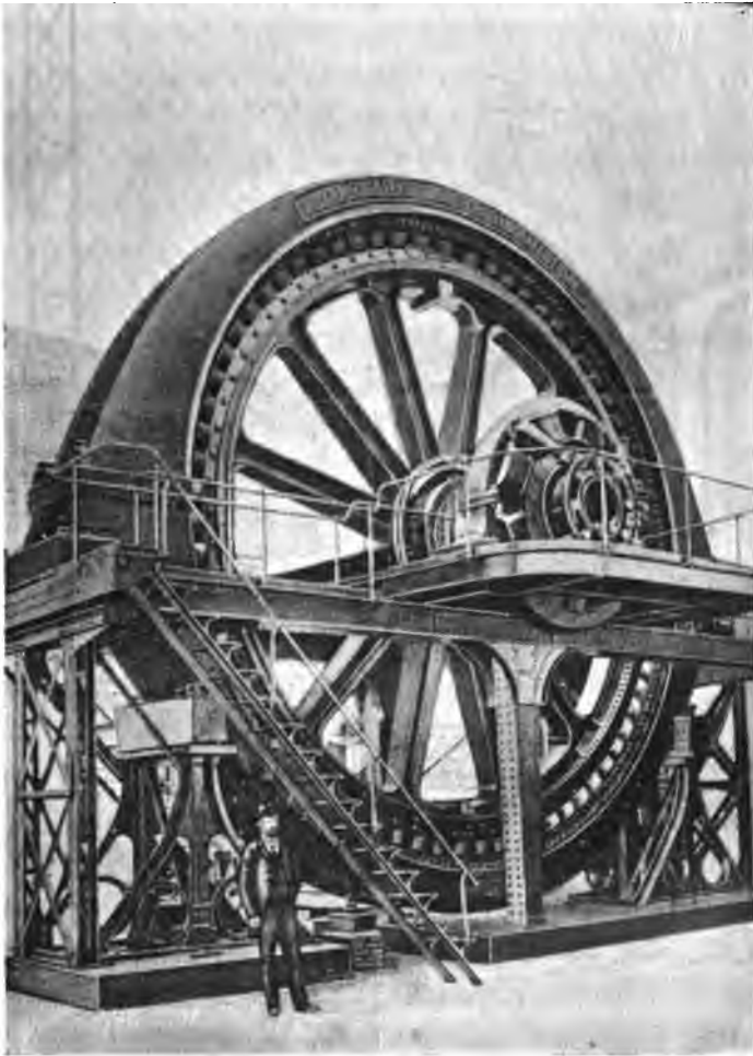
Alternateur triphasé de 3.000 KVA de l'Allgemeine Elektrizitäts Gesellschaft de Berlin.
